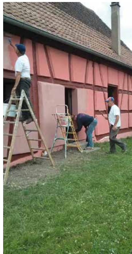
Restauration du foyer à Andolsheim par une équipe de bénévoles
